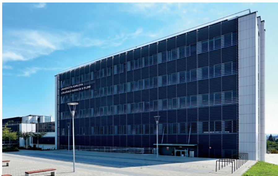
Budova teoretického ústavu
